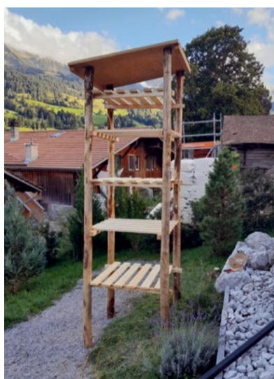
Das fertige Rohgerüst unseres Lebensturms. Foto: zvg
