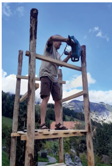
Unser Rohgerüst entsteht. Foto: zvg
